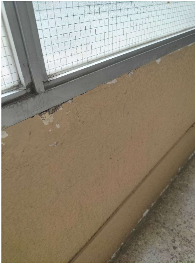
TROBAMENT ENTRE PARED I FINESTRA DEGRADAT
