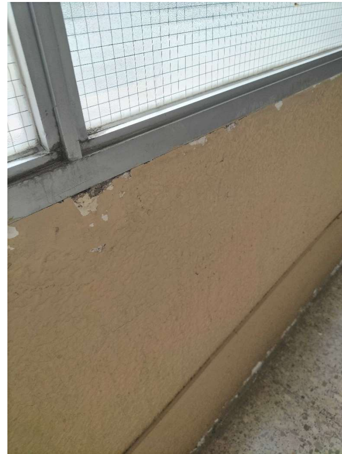
TROBAMENT ENTRE PARED I FINESTRA DEGRADAT
