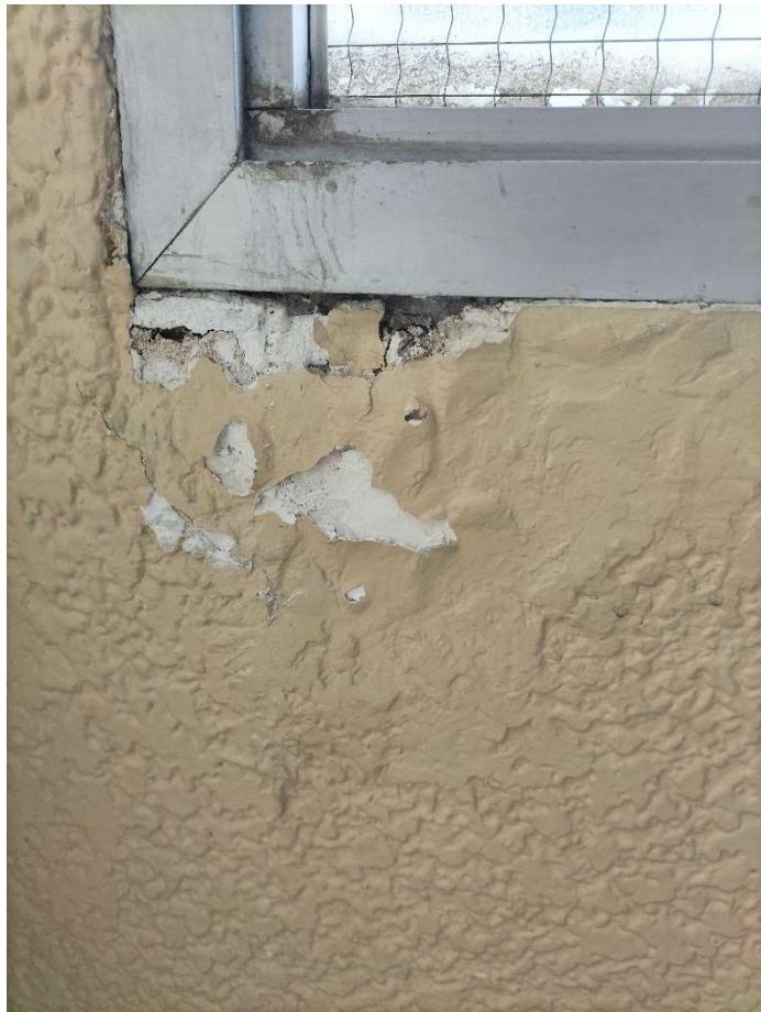
TROBAMENT ENTRE PARED I FINESTRA DEGRADAT
